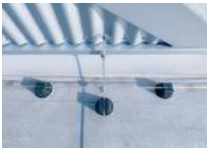
Свързване на металната фасада към мълниезащитната инсталация
