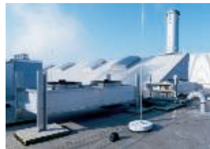
Изолирана мълниезащита на покривни съоръжения
