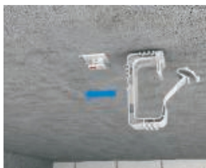
Закрепване на събирателната скоба Събирателната скоба "Grip" се поставя върху предварително отделения крепежен елемент.
