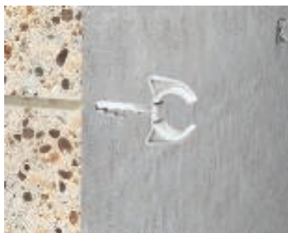
Приложение на скоба "Snap" Маркирайте линията на инсталацията и направете монтажни отвори.
