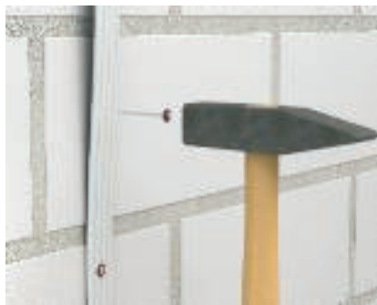
Приложение на стоманен пирон "Impru" Пиронът "Impru" се забива в средата между жилата на мостов проводник.
