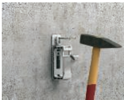
Закрепване с набивен дюбел Поставете набивния дюбел заедно с крепежния елемент в отвора и забийте с чук.
