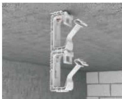
Нареждане една под друга Събирателните скоби могат да се свържат една под друга. В зависимост от натоварването и закрепването не се допуска взаимно свързване на повече от две събирателни скоби на ОБО.
