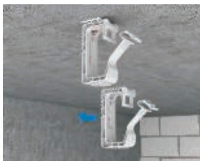
Нареждане една под друга Чрез патентования си профил събирателните скоби на ОБО могат да се свързват една под друга.
