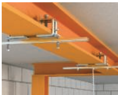
Приложение трегер-клеми тип 339 С трегер-клемите тип 339 се закрепват профилни шини към стоманени трегери, закрепването е чрез винтово затягане.
