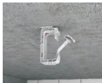
Готов монтаж на събирателна скоба Събирателната скоба се фиксира сама, щом достигне правилното положение.
