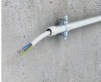
Приложение краен предпазен елемент за тръби Кабелите и проводниците се изтеглят през тръбата.
